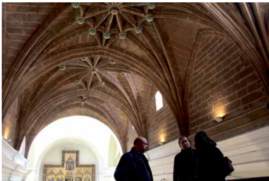
Alfonso Adán visitó las obras de restauración de las bóvedas de la parroquial de San Pedro Apóstol junto con los párrocos y miembros de la plataforma de apoyo a las obras.
